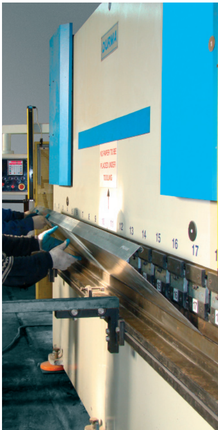
Fot. 1. Profiłowanie elementu pomostu stalowego technologią gięcia na prasie krawędziowej
