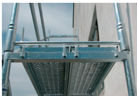
Fot. 4. Zabezpieczenie pomostu przed wyparciem na rusztowaniu ramowym
