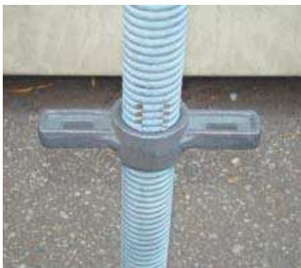
Fot. 3. Zabezpieczenie przed wykręceniem nakrętki
