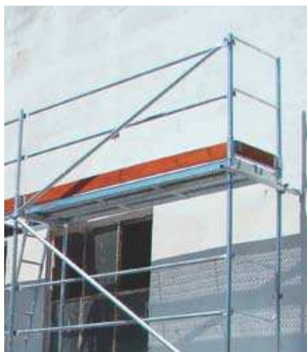
Fot. 9. Zabezpieczenie najwyższej kondygnacji (ramka ze zintegrowanymi poręczami)
