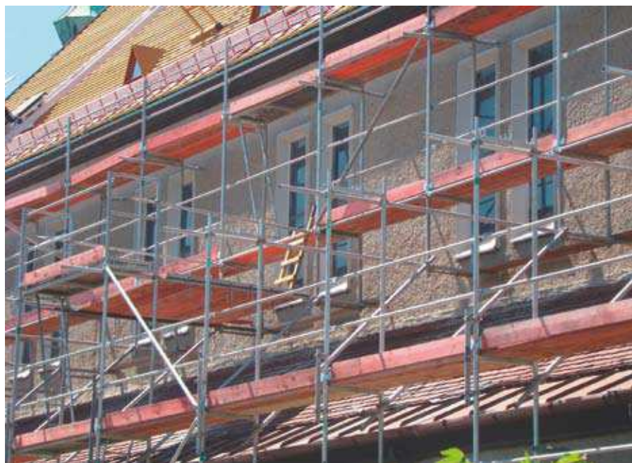
Fot. 11. Rury luzem jako połączenie i wzmocnienie konstrukcji
