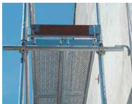
Fot. 10. Rura wykorzystana do połączenia rusztowania z elewacją
