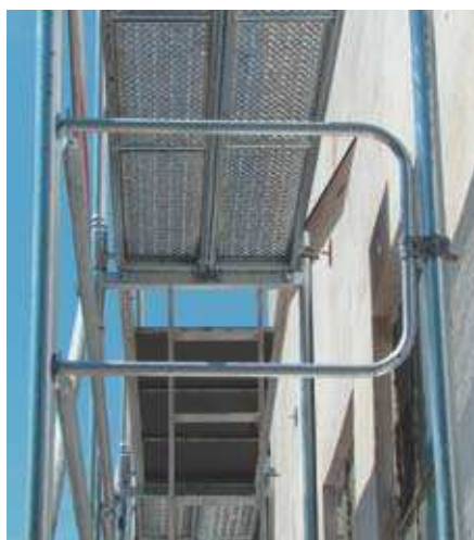
Fot. 8. Zabezpieczenie rusztowania w płaszczyźnie prostopadłej do ściany
