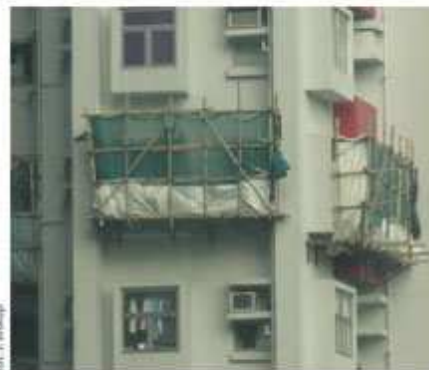
Fot. 4. Rusztowanie wiszące oparte na konsolach (tzw. truss-out bamboo scaffold)
