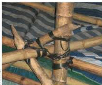
Fot. 1. Węzeł rusztowania bambusowego
