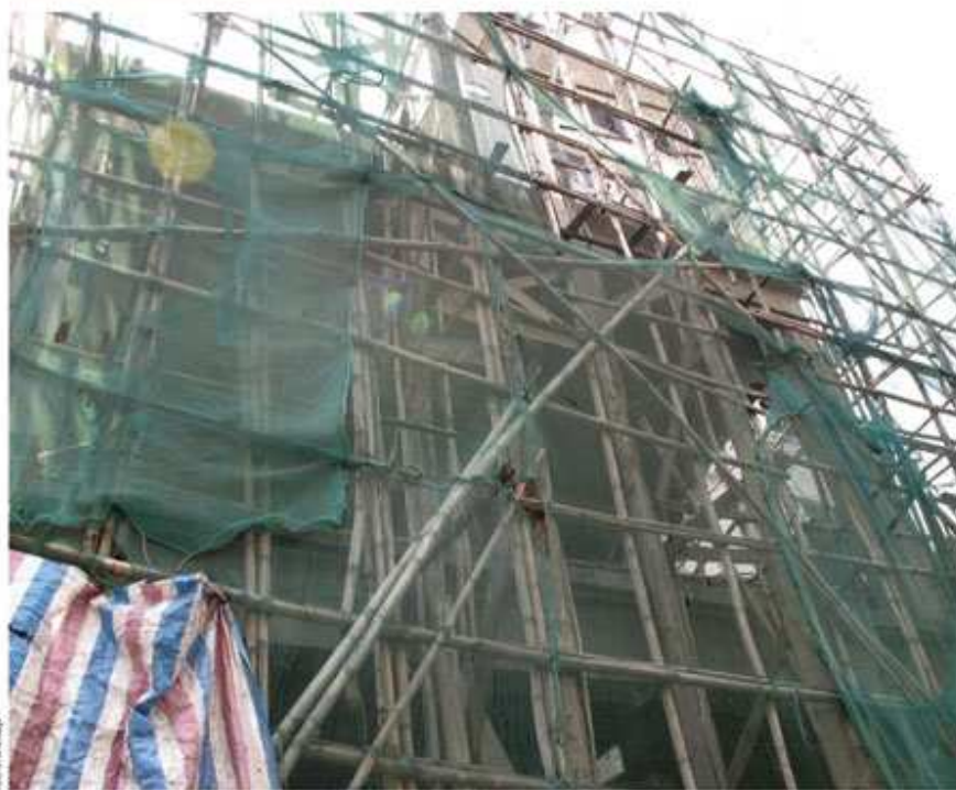
Fot. 6. Gęszcz pędów czyli elewacyjne rusztowanie bambusowe
