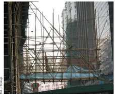
Fot. 5. Konstrukcja podwieszona (tzw. signage scaffold)
