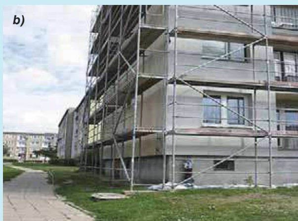
Fot. 3. Przykłady rusztowań bez zabezpieczeń bocznych
