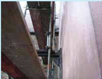
Fot. 2. Brak zabezpieczeń w przypadku, gdy odległość od pomostu rusztowania do ściany jest większa niż 0,2 m
