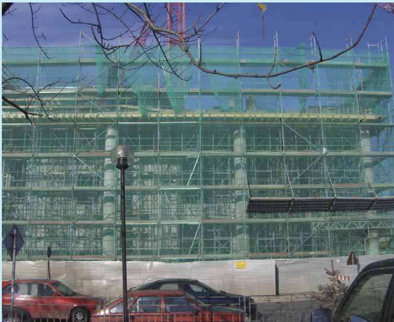
Fot. 4. Przykład rusztowania ochronnego
